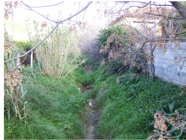
F1 Sección cauce aguas arriba
