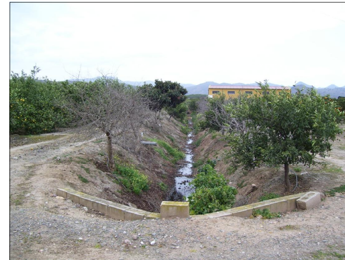
F1 Sección cauce aguas arriba
