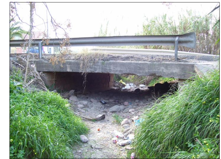
F3 Sección cauce aguas arriba
