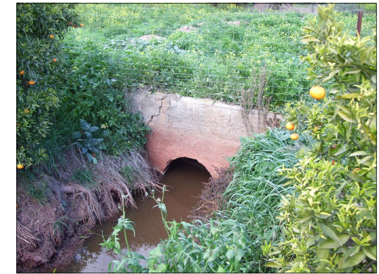
F1 Sección cauce aguas abajo
