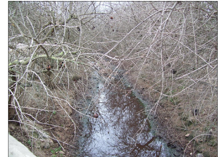
F2 Sección cauce aguas abajo
