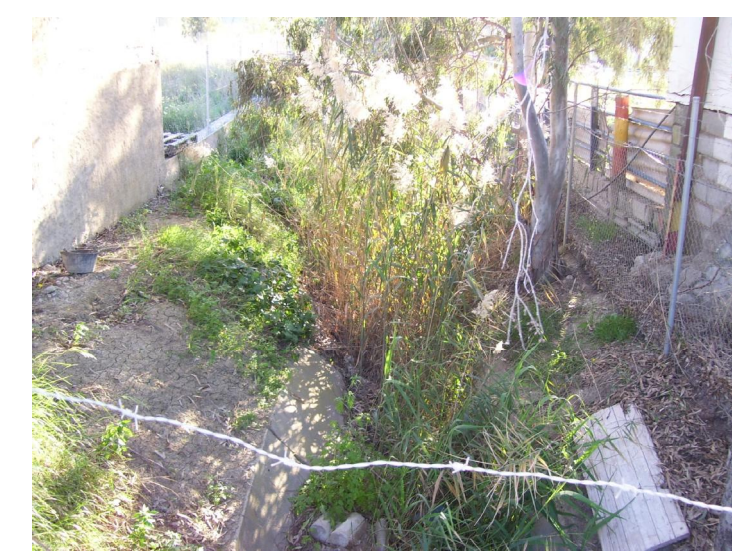
F1 Sección cauce aguas abajo
