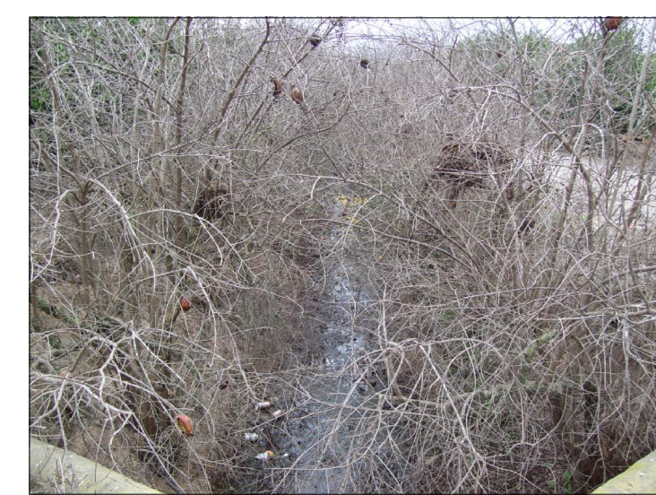
F3 Sección cauce aguas arriba
