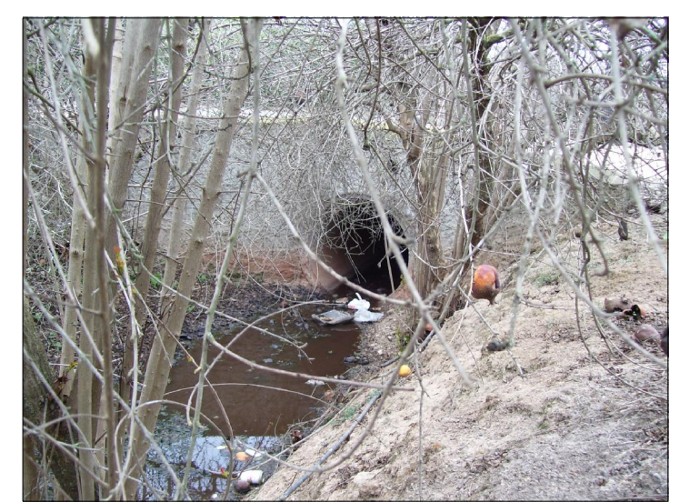
F4 Sección cajón aguas arriba
